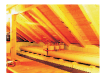
Stockage allongé dans des combles
