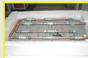
Isolation du réservoir
