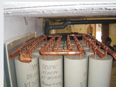
Raccordement des cellules selon Tichelmann avec 2 échangeurs thermiques.
