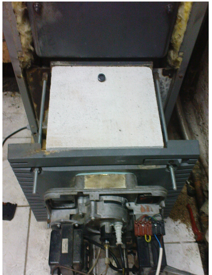
Prolongement du foyer en béton cellulaire
