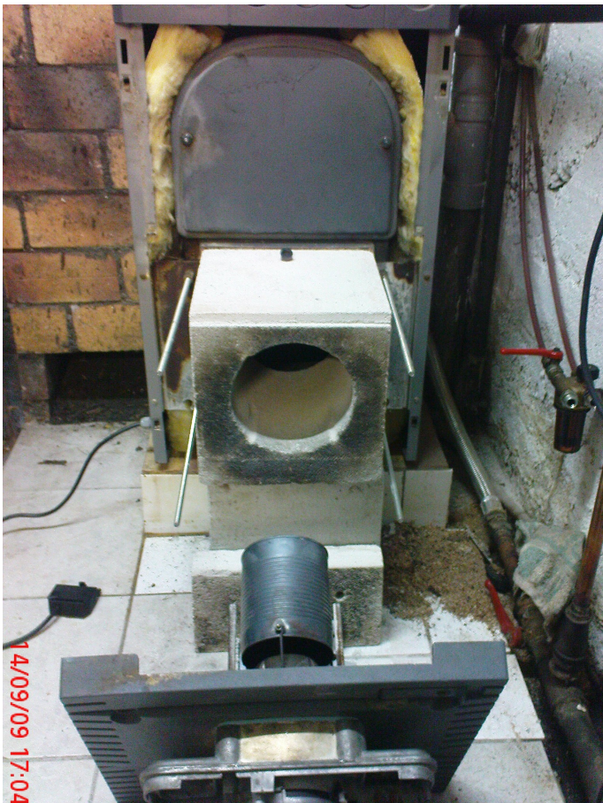
Prolongement du foyer en béton cellulaire
