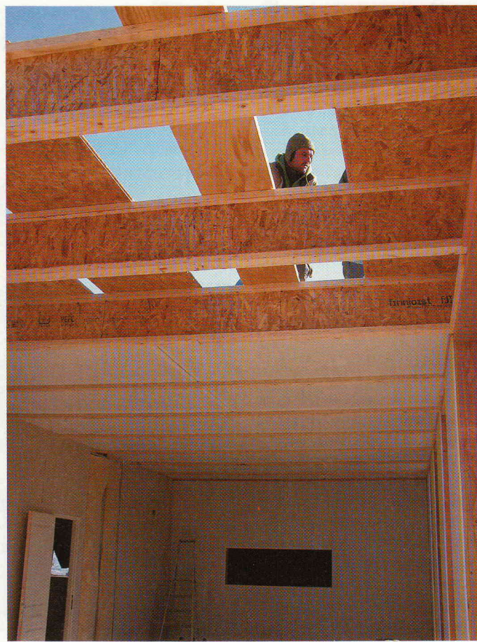
La charpente est en poutres en I, avec une âme en triply qui se perce aisément pour faire passer toutes les gaines techniques. Plus légères que des poutres en bois massif, elles sont plus faciles à manier et moins onéreuses, pour les mêmes résistances mécaniques.
