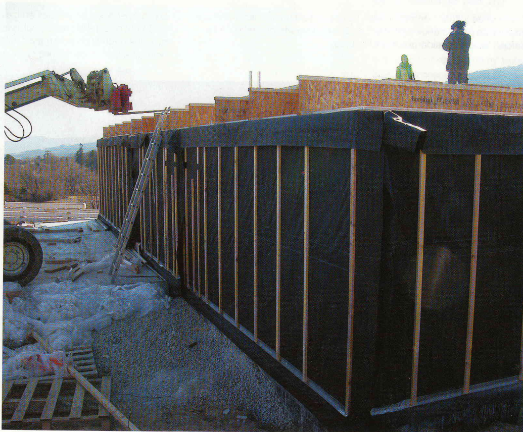
L'ossature bois a été préfabriquée en atelier. Avec son pare-pluie, elle est prête à recevoir le bardage en mélèze.
