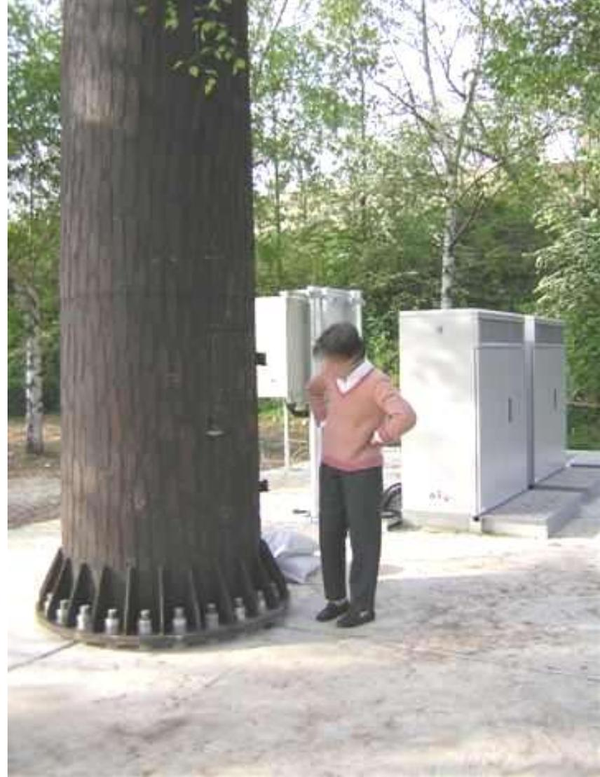
Pour monter dans l'arbre il faut passer par la porte. Les racines ? 24 gros boulons et tiges le tiennent fixé dans le béton.
